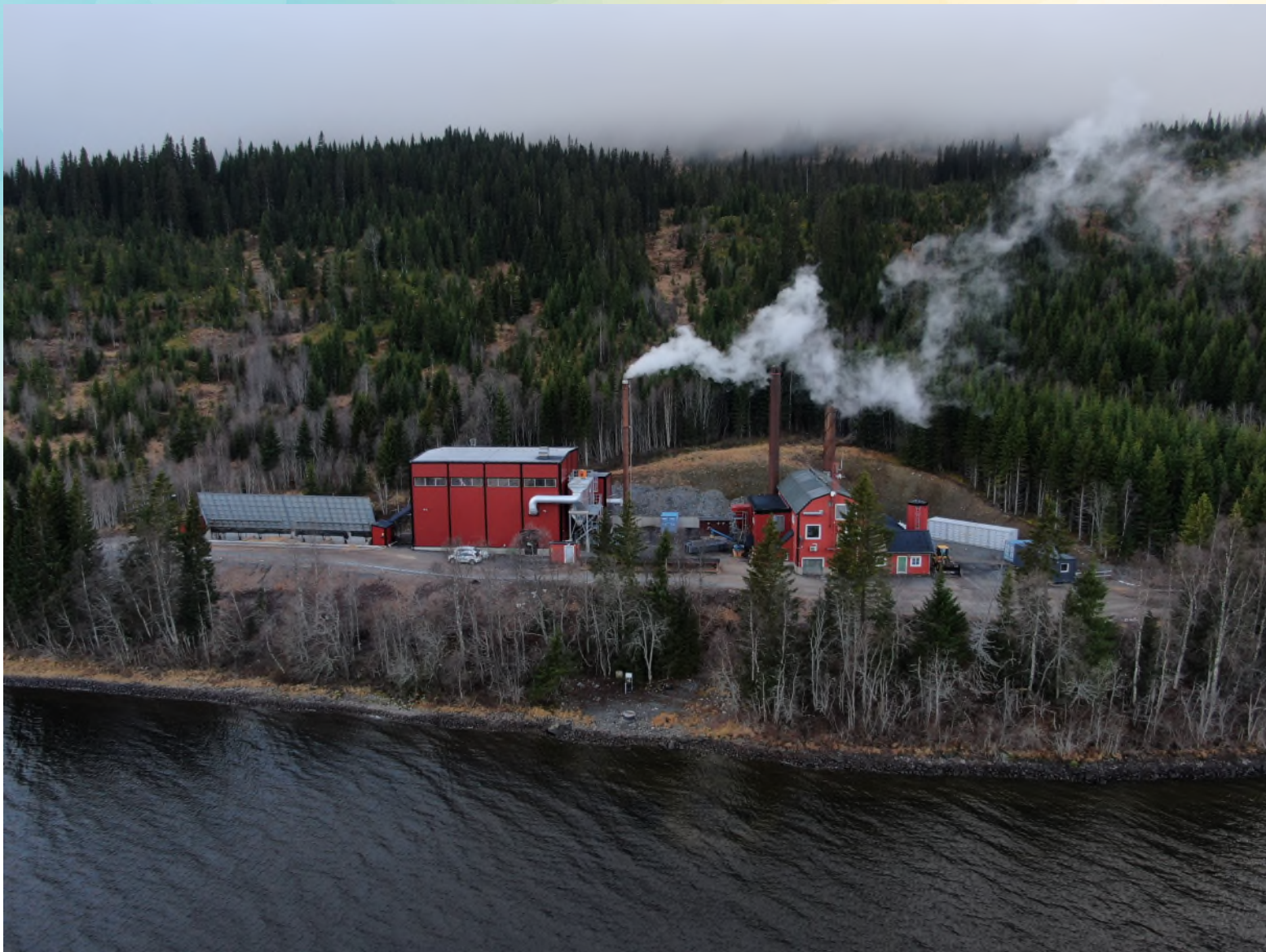
Bild över anläggningen på Sösia. Från vänster: bränsleficka, FB3, FB2 och oljepanna.
