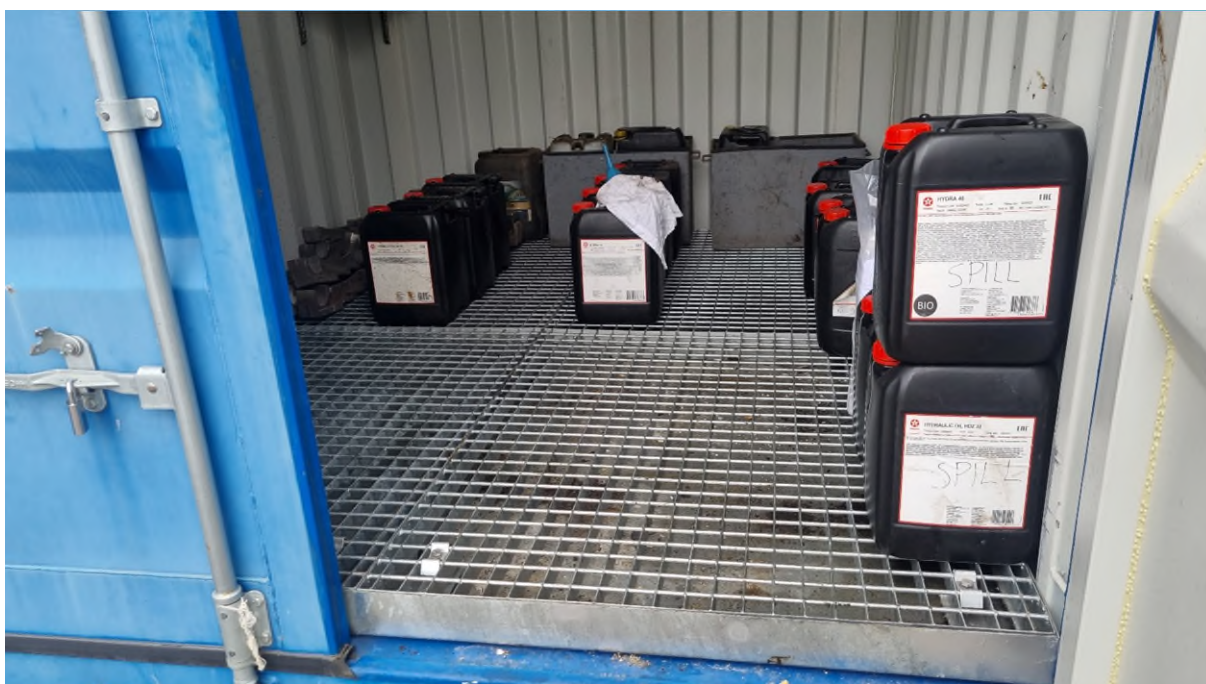
FIGUR 15 INUTI CONTAINER MED SPILLSKYDD FÖR FÖRVARING AV KEMIKALIER
