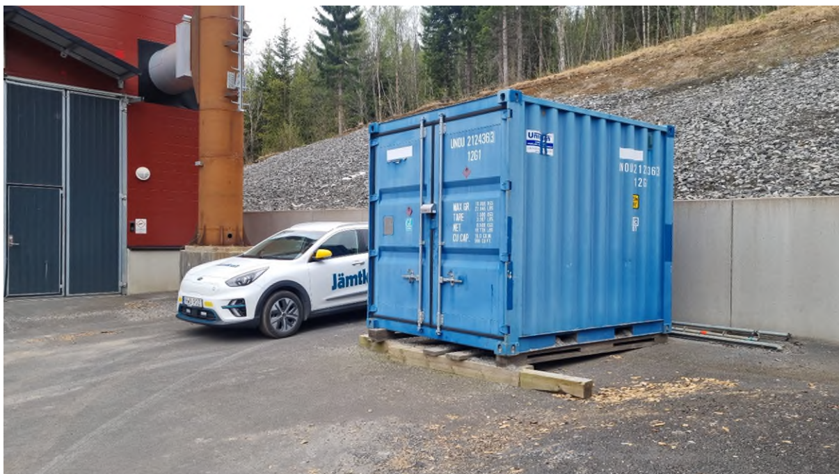
FIGUR 14 CONTAINER FÖR FÖRVARING AV KEMIKALIER
