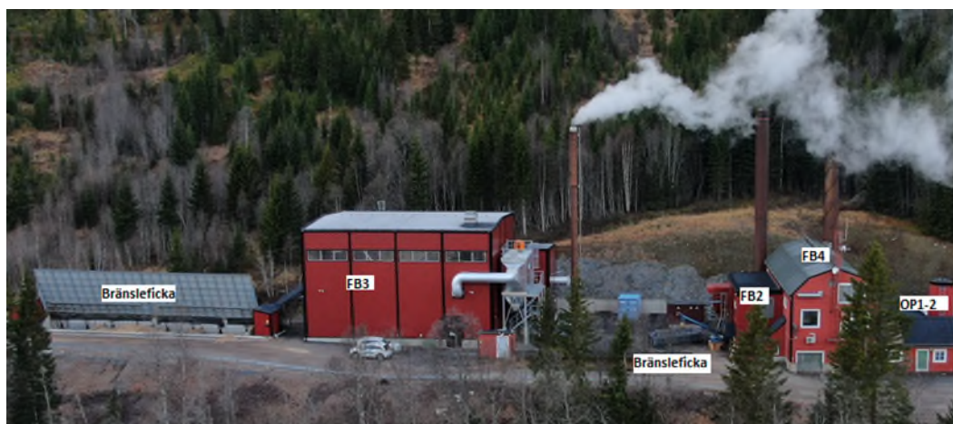
FIGUR 7 SÖSIA I ÅRE MED PLACERING AV DE BEFINTLIGA PANNHUS MED PANNA FB3, FB2 OCH KOMMANDE FB4, OP1 OCH KOMMANDE OP2 SAMT BRÄNSLEFICKOR.
