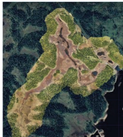
Greningen nedre, det bruna området visar den torrlagda botten efter utrivning av dammen. Kvarnån har återfått sin naturliga sträckning
